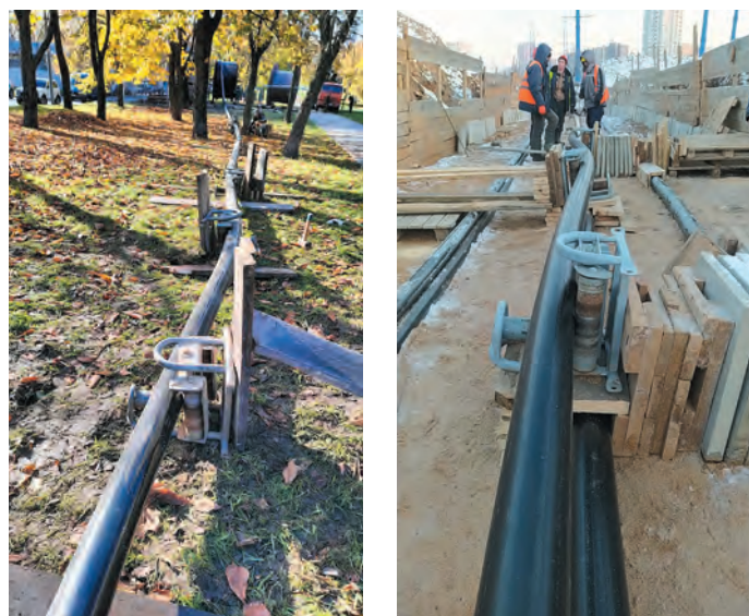
Рис. 3. Расположение роликов "змейкой" при протяжке кабеля
