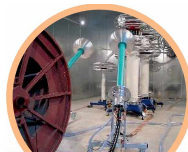
Испытательная станция Haefely до 350 кВ
